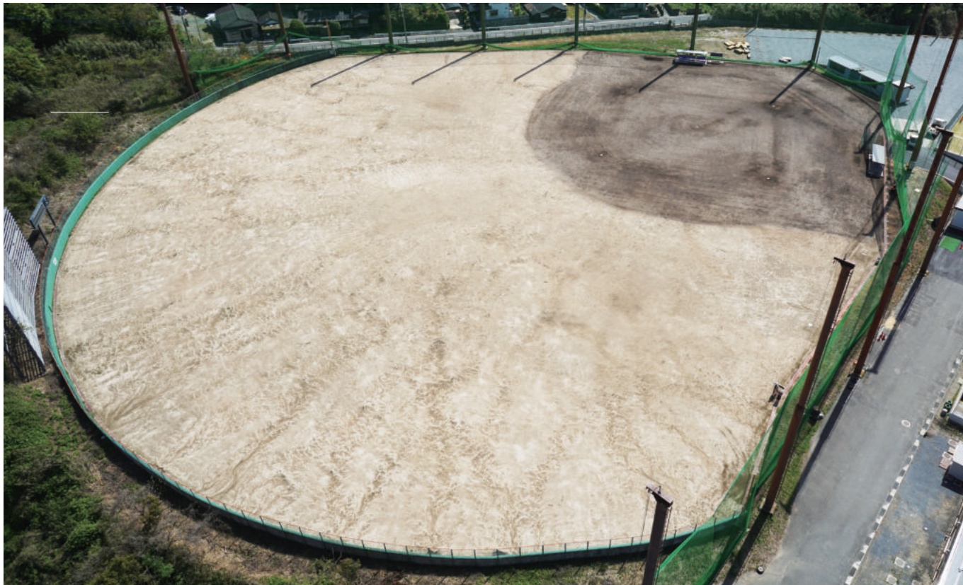
福岡県 鞍手統合中学校野球場
