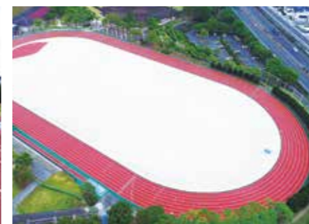
福岡県 大野城市総合公園「まどかパーク」陸上競技場
