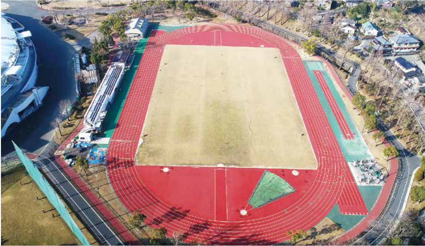
長崎県 長崎県総合運動公園陸上競技場
