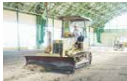
2 仕上げ地均し
