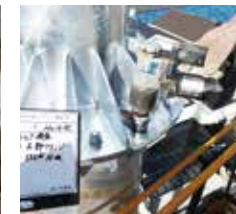
2 建て込み (ボルト締め状況)
